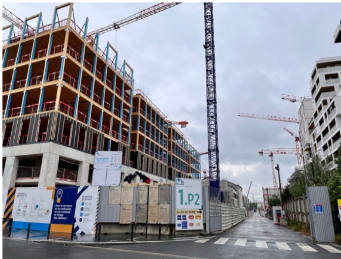
写真 8 見渡す限りの広大な土地で選手村の建設が進む
