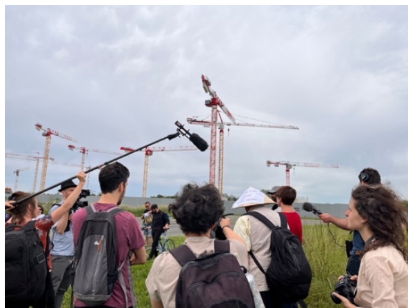
写真3 メディア村建設のクレーンが立ち並ぶ
