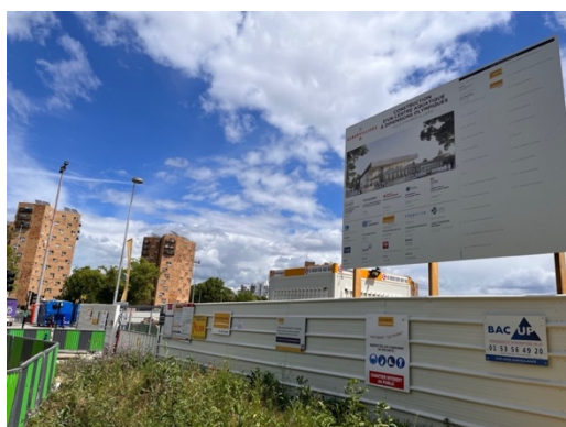
写真12 アクアティクス・センターの建設計画を掲示する看板。裏側が工事現場
