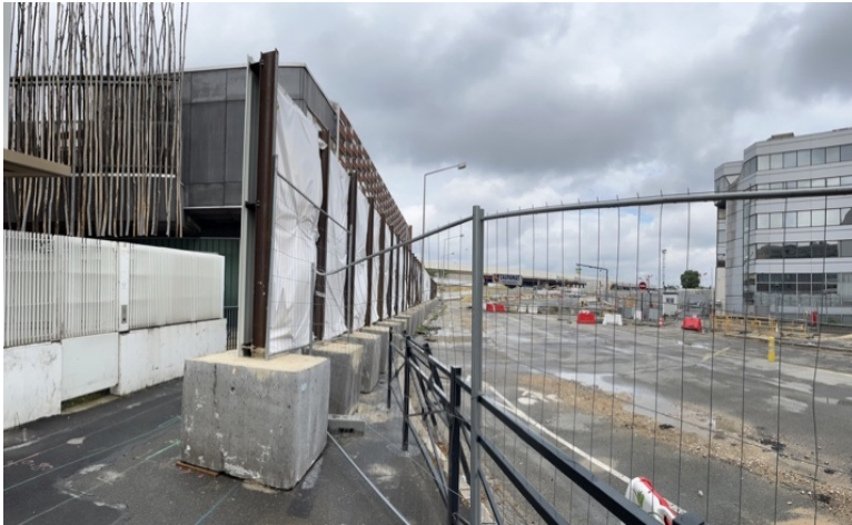
写真9 学校（左）のすぐ横で行われている大規模な高速道路出口の建設工事
